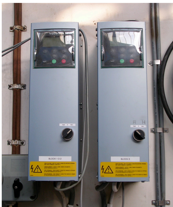
Foto 1. Varvtalsregulatorer installerade på befintliga cirkulationspumpar i efterhand. Varvtalsregulatorerna är monterade på väggen.
