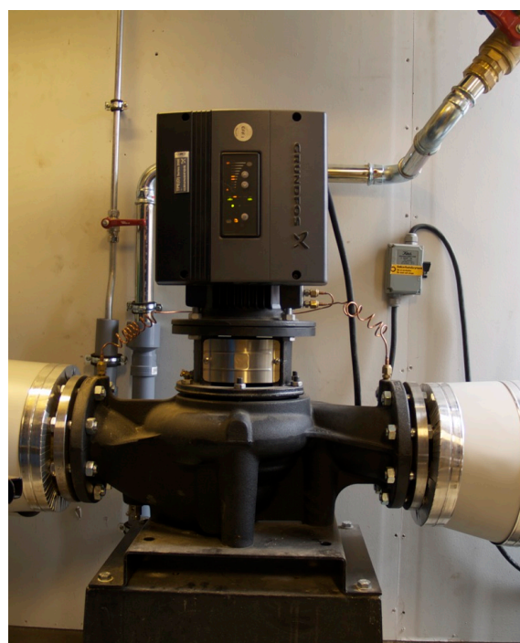
Foto 2. Pump levererad med varvtalsreglering från början.
