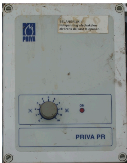
Foto 1. Exempel på varvregulator för cirkulationsfläktar. Flera fläktar kan normalt kopplas till samma regulator.
