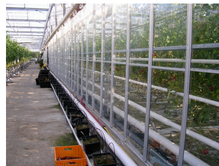
Foto 2. Matningsrör och värmerör längs en vägg som tidigare var en yttervägg. Värmerören bör tas bort och matningsrören isoleras.
