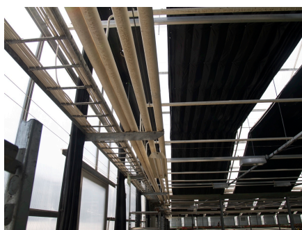
Foto 3. Oisolerade matningsrör i taket, som sitter för tätt för att kunna isoleras.
