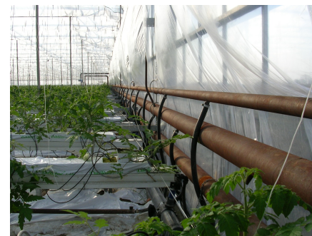
Foto 4. Matningsrören fungerar här även som värmerör för ytterväggen. Lösningen fungerar utmärkt så länge växthuset har ett värmebehov, men en stor del av odlings säsongen har man inget värmebehov längs ytterväggen. Matningsröret ger då upphov till betydande värmeförluster. Ett värmesystem bör ej konstrueras på det här viset.
