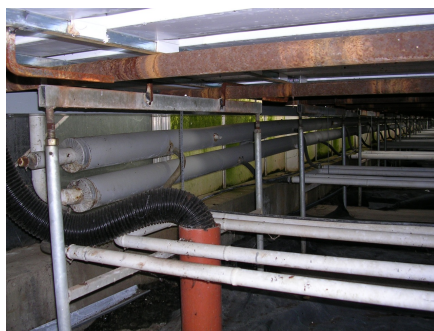
Foto 1. Isolering av matningsrör till bordvärmen.
