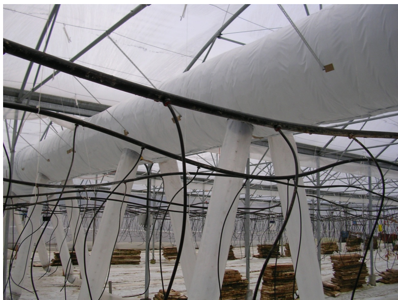
Foto 2. Kanalsystem för distribution av varmluft till plastfolieslangar, isolerat med mineralullsmatta och täckt med vit, UV-tålig plastfolie.
