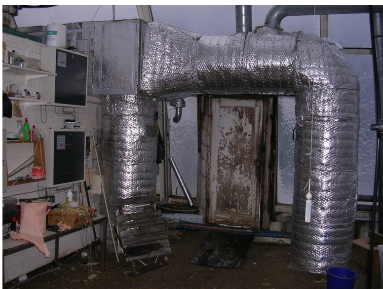
Foto 1. Kanalsystem vid varmluftspanna, isolerat med värmetålig mineralull och aluminiumfolie.
