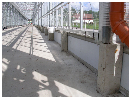
Foto 3. Sockeln vid transportgångar kan utan vidare isoleras en bra bit upp.
