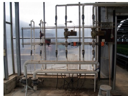
Foto 4. Väggpartiet bakom shuntgrupperna kan med fördel isoleras, då ljusinsläppet är försumbart samtidigt som värmeförlusterna är betydande eftersom rören här håller en hög temperatur.
