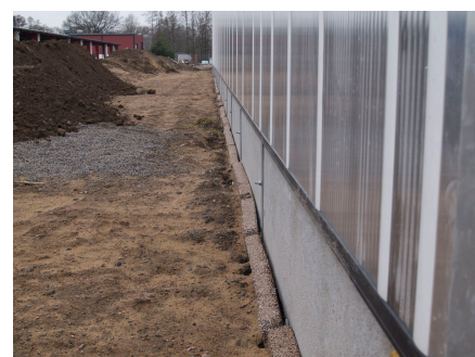
Foto 6. Grundisolering med Isodrän i ett nybyggt ventblock.
