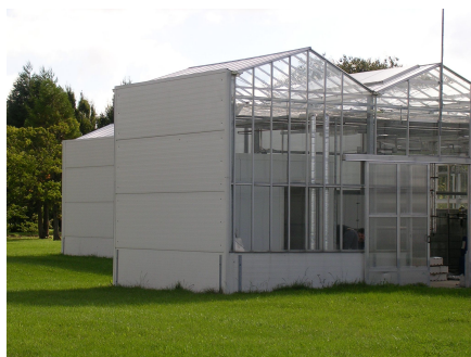
Foto 5. Norrväggen är isolerad med 50 mm väggpanel. Panelen är vit på insidan för bästa ljusreflektion.
