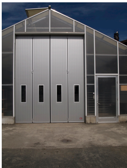
Foto 2. En industriport med rejäla tätningsslister och god isolering.
