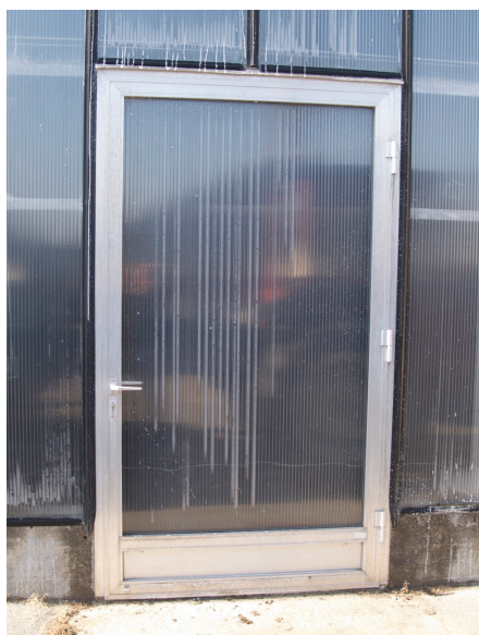
Foto 1. En normal växthusdörr, som inte har speciellt bra isoleringsförmåga.
