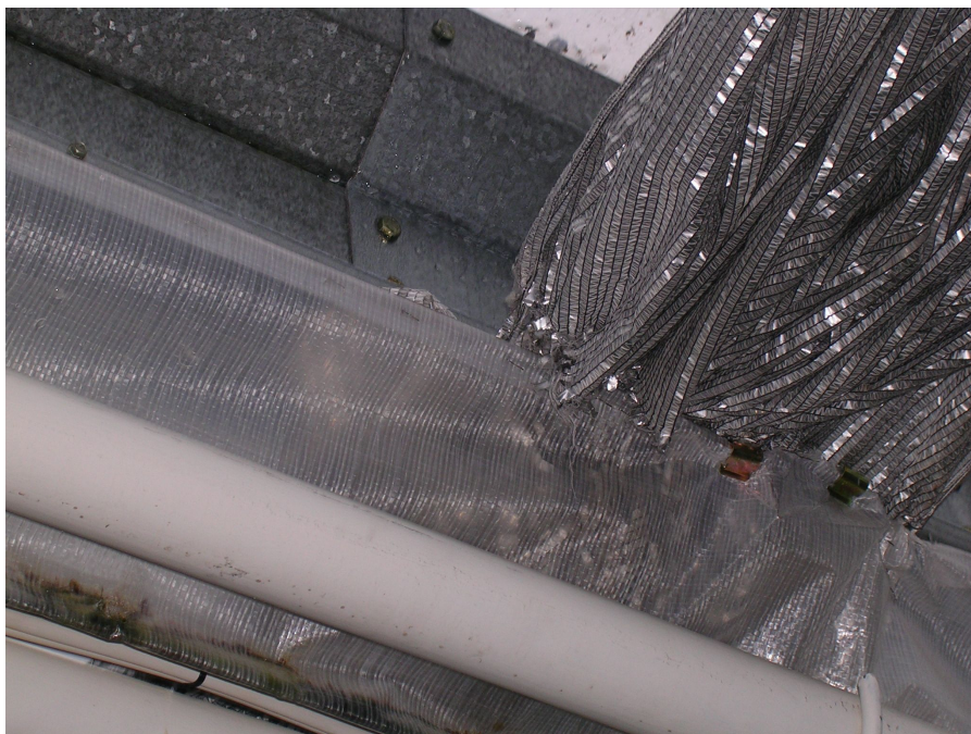
Foto 11. En nästan nyinstallerad väv har redan skavts sönder mot kallrasfickan på grund av att den ligger an för hårt. Väven måste genomgå en större lagning av kunnig installatör.
