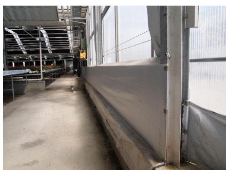
Foto 7. En rejäl kallrasficka som hålls mot grundmurens överdel med hjälp av en längsgående ståltråd. Väven fortsätter därefter en bra bit ner över muren och sluter ordentligt tätt.
