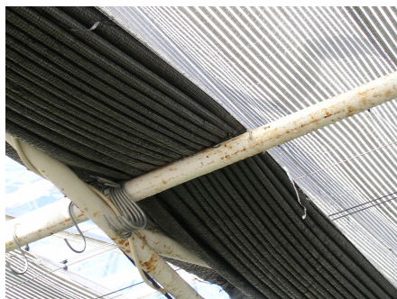
Foto 12. Väven ligger an mot värmeröret, som är rostigt. Rosten kommer att riva sönder väven och förstöra installationen. Det hade varit bättre att spanna t.ex. en rostfri vajer ovanför värmeröret som väven kunde glida mot.
