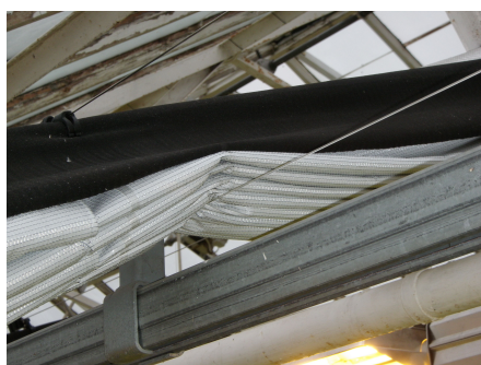
Foto 13. En vajer har spänts mellan inredningsdetaljen och väven, så att väven går fri och inte rivs sönder.
