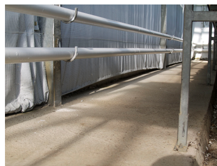
Foto 15. Väv som inte monterats med krympmån och som nu glipar mot golvet, vilket resulterar i att kall luft rinner in i växthuset nere vid golvet. Mycket av vävens energibesparing går här förlorad.
