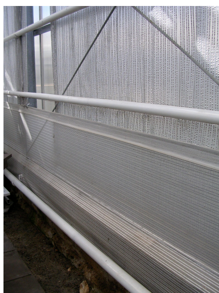
Foto 10. En snyggt installerad kallrasficka vid sockeln. Väven ligger ordentligt an mot sockeln med hjälp av fastspända vajrar. I överkant är väven vikt över en vajer och sydd istället för häftklamrad.
