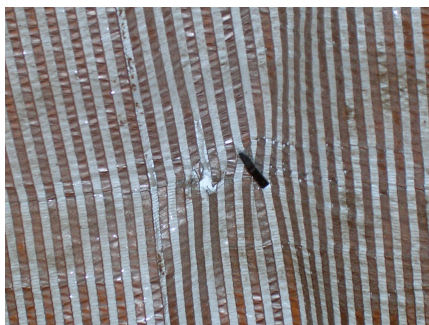
Foto 1. Väv som börjat slitas sönder vid vävkroken. Hålet måste lagas snarast för att inte bli större när det blåser.
