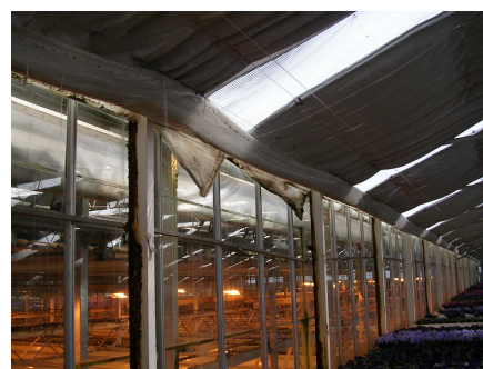
Foto 6. En kallrasficka har fyllts med vatten och till sist brustit.
