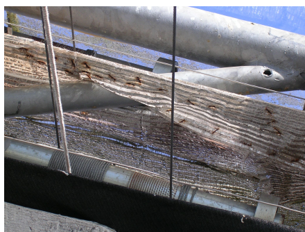
Foto 9. Här har man sparat några kronor på installationen och inte använt rostfri klammer. Så här får det inte se ut!
