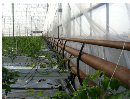
Foto 4. Kall luft är tyngre än varm. Här ser man hur den kalla luften från väggen trycker ut plastfolien från väggen.
