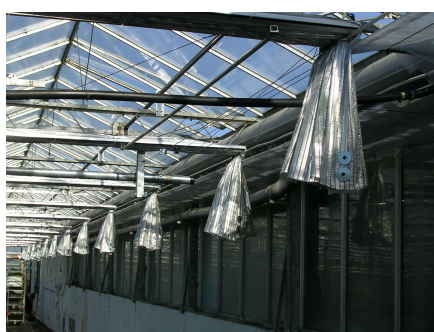
Foto 8. En rejäl kallrasficka vid takfoten, där den rörliga väven har ett ordentligt överhäng så att den orkar sluta tätt när den kalla luften trycker på.
