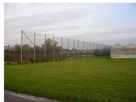
Foto 1. Exempel på ett vindskydd med plastat stål nät. Det här vindskyddet är egentligen lite för gles för att fungera optimalt.
