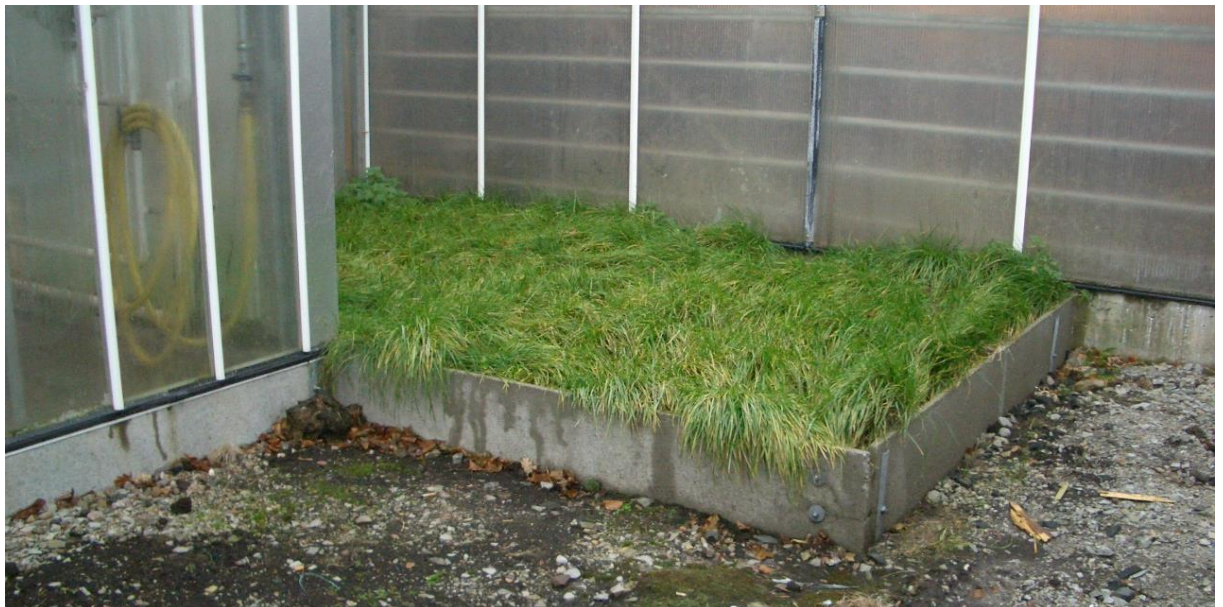
Figur 5. Utvändig biobädd med påfyllnadsplatsen precis innanför. En dränkbar pump för vattnet vidare till biobädden som ligger väl intill växthusen och därmed hålls frostfritt största delen av året.
