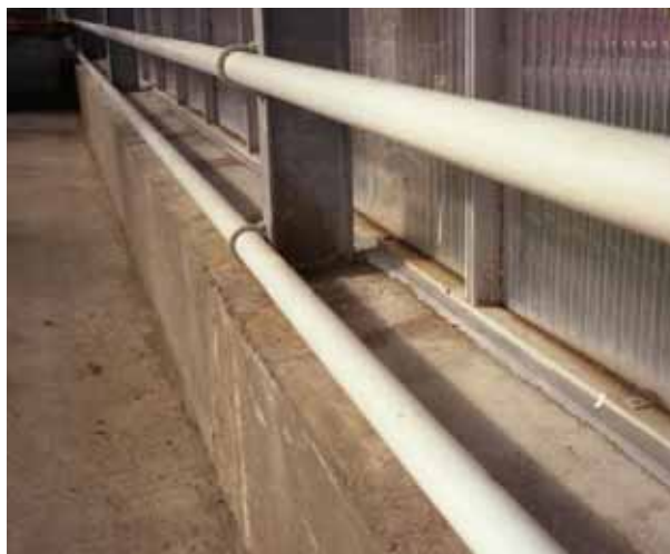
Figur 9. Helgjuten grundmur där stolparna är nergjutna i grundmuren. Notera att murens ovansida sluttar för att kondensvatten ska rinna av.
