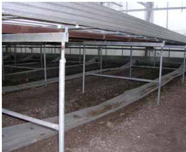
Figur 25. Luftburen värme vid odling på bord. Längs växthusets långsida, vid bordens kortsida, går en spirokanal. Vid varje bord finns ett uttag för en plastfolieslang.
