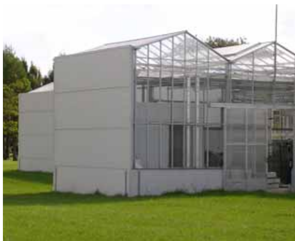
Figur 18. Exempel på helisolerad norrvägg från Årsløvs forsøksstation utanför Odense i Danmark. Väggen är isolerad med väggpaneler 50 mm tjocka med vit insida för bästa ljusreflektion.
