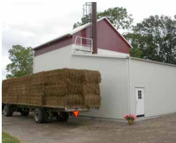
Figur 28. Anläggning för halmeldning med panna och 200 m 3 ackumulatortank. Foto: Johan Ascard.
