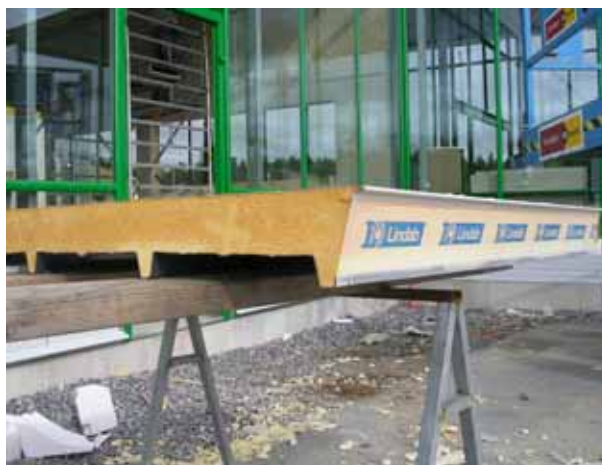
Figur 19. Tvärsnitt av väggpanel. Både på insida och utsida finns lackerad stålplåt och däremellan ligger ett isoleringsmaterial. Olika material kan användas, så som polyuretanskum, stenull och polystyren.
