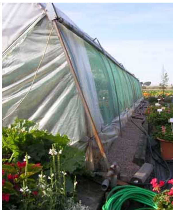
Figur 23. Båghus med sidoventilation. Plastfolien rullas upp på ett stål rör. Upprullningen kan ske antingen manuellt eller automatiskt. Som vind- och djurskydd är hela öppningen försedd med ett nät.
