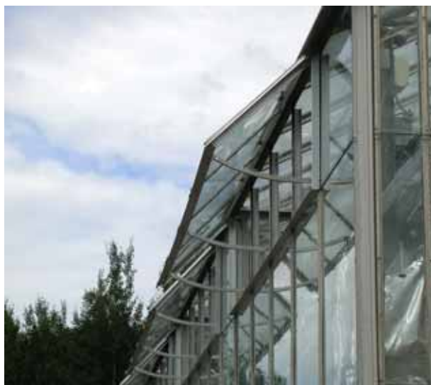
Figur 22. Fribärande hus med sidoventilationsluckor.
