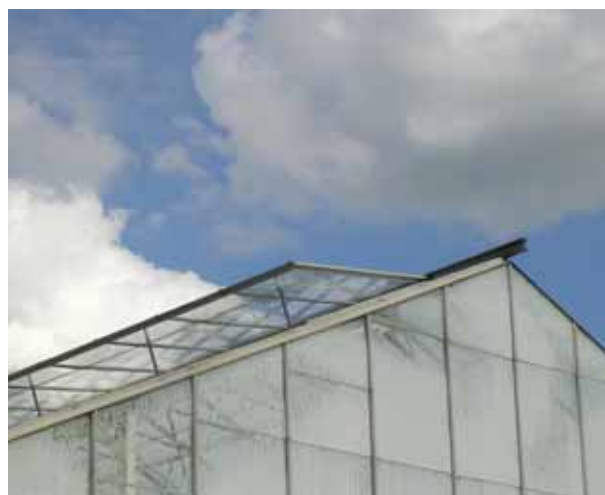
Figur 21. Fribärande hus med nockventilation.
