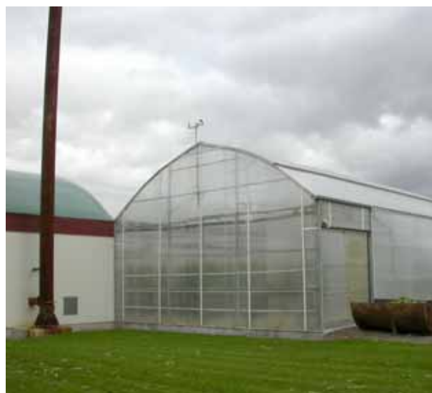
Figur 17. Multispanhus av fabrikat Richel med dubbel plastfolie i väggar och tak. Foto: Johan Ascard.
